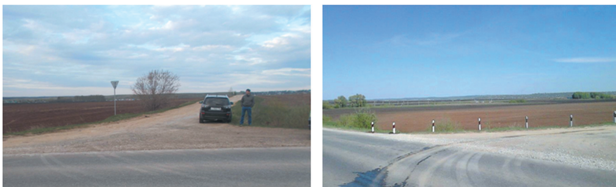
Рис. 4. Фотоснимки с выявленными недостатками УДС и с устраненными впоследствии
