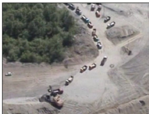
Мониторинг места работ
