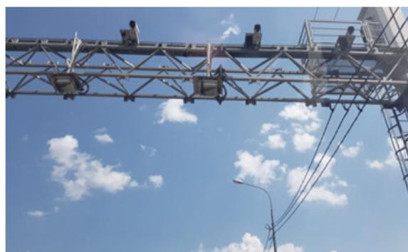
Рис. 2. Размещение датчиков над проезжей частью магистрали
