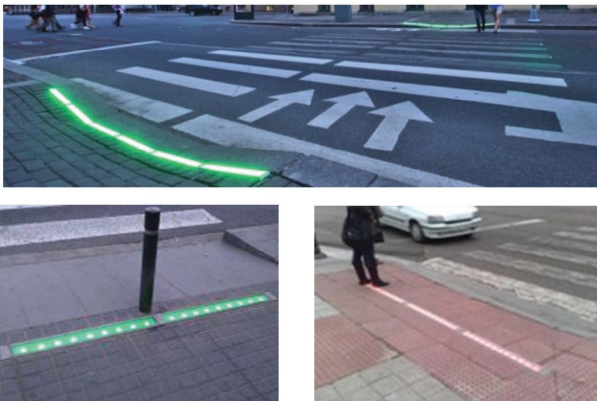
Рис. 4. Применение тактильных светодиодных полос безопасности
