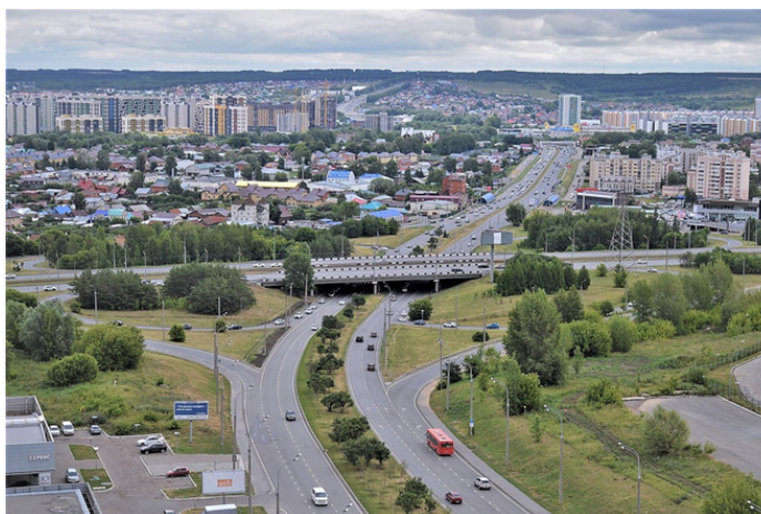
Рис. 5. Путепровод №4 по проспекту Победы на пересечении с улицами Аграрная и Мамадышским трактом
