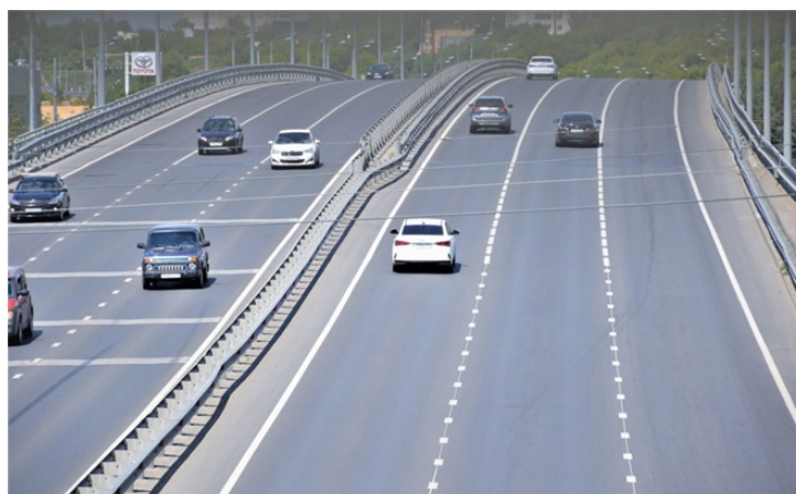
Рис. 3. Путепровод № 2 по проспекту Универсиады на пересечении с улицей Танковая, развязка на Танковом кольце
