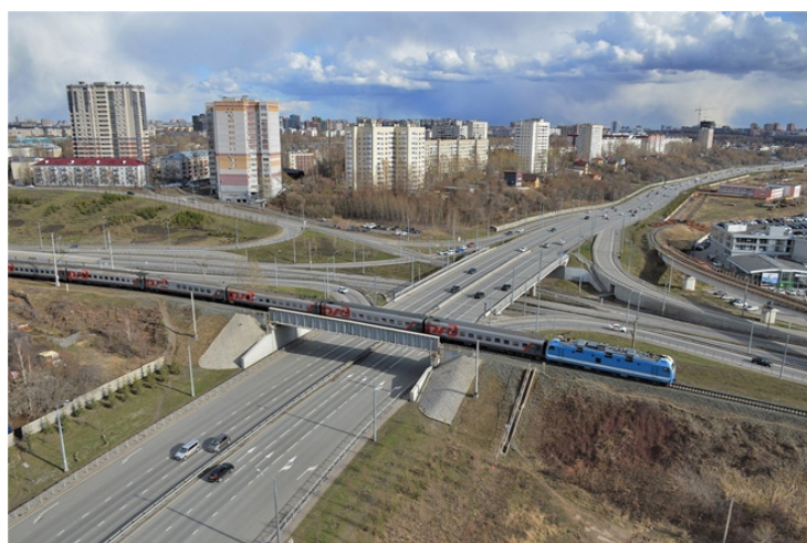
Рис. 4. Путепровод № 3 по проспекту Универсиады на пересечении с улицей Даурская
