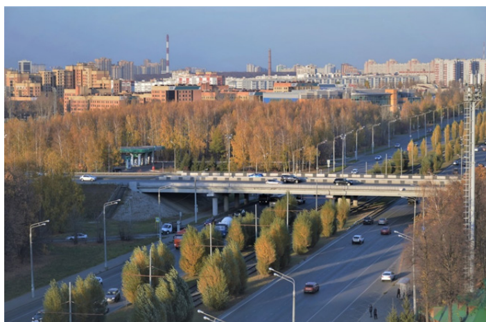
Рис. 2. Путепровод № 1 на транспортной развязке на пересечении проспекта Победы и Оренбургского тракта
