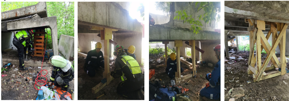
Рис. 1. Виды крепей (слева-направо: «Колодец», «Т-образная», «П-образная», решетчатая)
