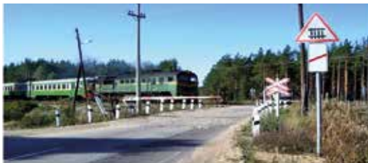
Рис. 29. Железнодорожный переезд со шлагбаумом
